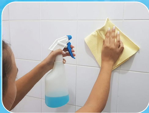
1. Dégraisser le mur
